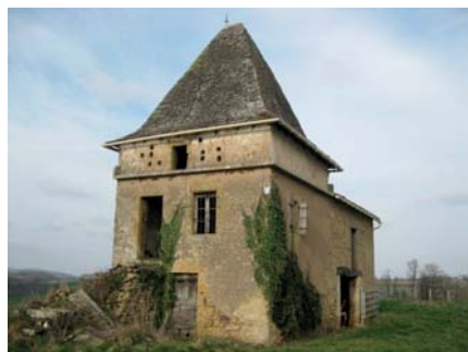
Ancien pigeonnier sur la route de Galgan.
